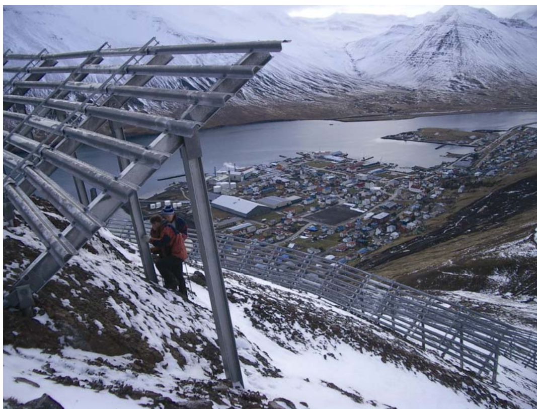
Mynd nr. 4. Upptakastoðvirki, áætlað er að upptakastoðvirki í Kubbanum verði í sama formi og þau sem sjást á myndinni sem tekin er ofan byggðarinnar í Siglufirði. Ljósmynd, Stefan Margreth.
