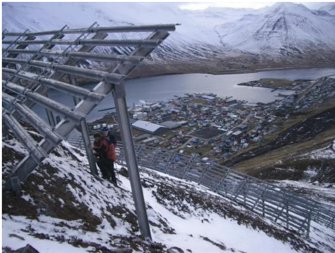
Mynd nr. 4. Upptökustoðvirki, áætlað er að upptökustoðvirki í Kubbanum verði í sama formi og þau sem sjást á myndinni sem tekin er ofan byggðarinnar í Siglufirði. Ljósmynd, Stefan Margreth.
