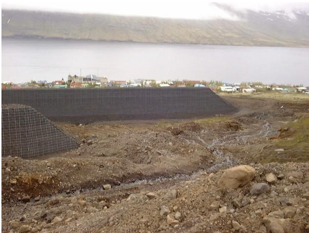
Mynd nr. 3. Varnargarðar á Neskaupstað. Áætlað er að varnargarður við Holtahverfi verði með svipuðu formi og varnargarðar á Neskaupstað, hér sést sú hlið garðanna er snýr að fjallinu. Ljósmynd, Framkvæmdasýsla ríkisins.
