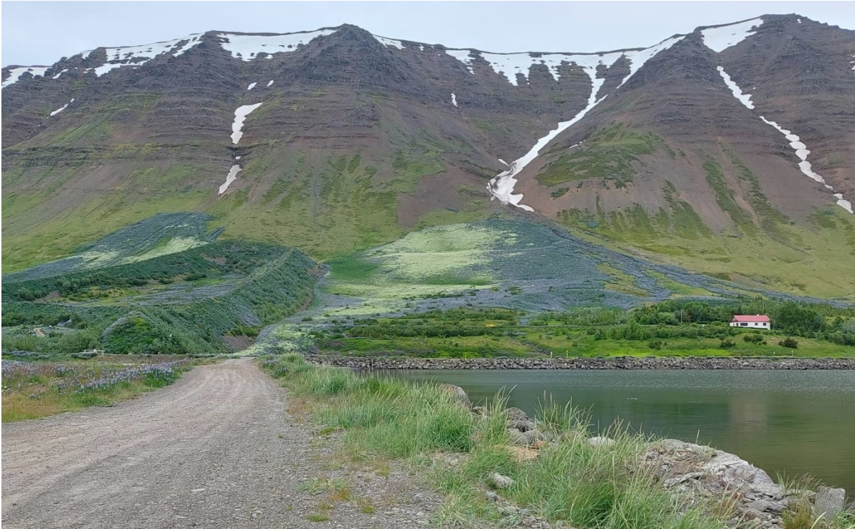
Mynd 3-1 Ásýnd af varnargörðum ofan Flateyrar og skóglendis við Sólbakka í júlí 2022. Ljósmynd: Aðalheiður E. Kristjánsdóttir.
