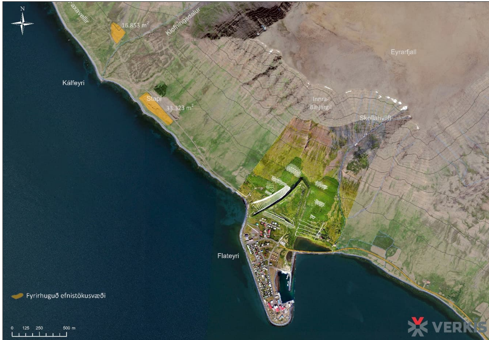
Mynd 2-2 Umfang fyrirhugaðra efnistökusvæða utan framkvæmdarsvæðis. Flatarmál Klofningsnámu er um 33.000 m 2 (nær Flateyri) og gömlu námunnar er um 17.000 m 2 (fjær Flateyri).
